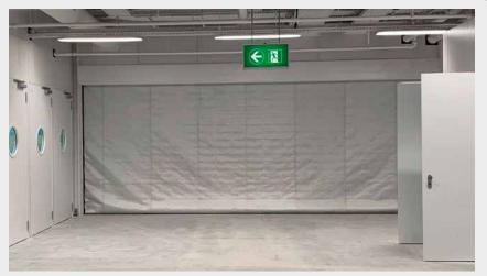
Die Steuerung kann an jedes beliebige Feuer-oder Rauchmeldesystem angeschlossen und gesteuert werden. Selbstverständlich ist auch ein separater Betrieb mit eigenständigen Rauchmeldern möglich.
