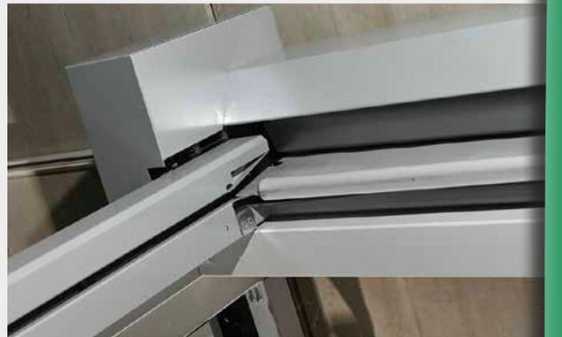
Laufschiene und Behangeinführung
